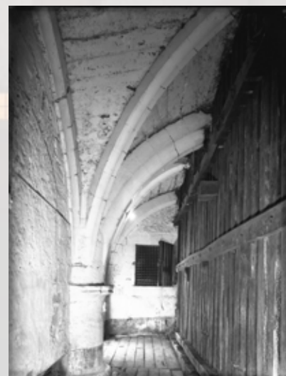
La Mal-Coiffée, couloir de surveillance des grands mitards. Il est éclairé et aéré uniquement par des soupiraux grillagés que l'on peut voir aux extrémités.
