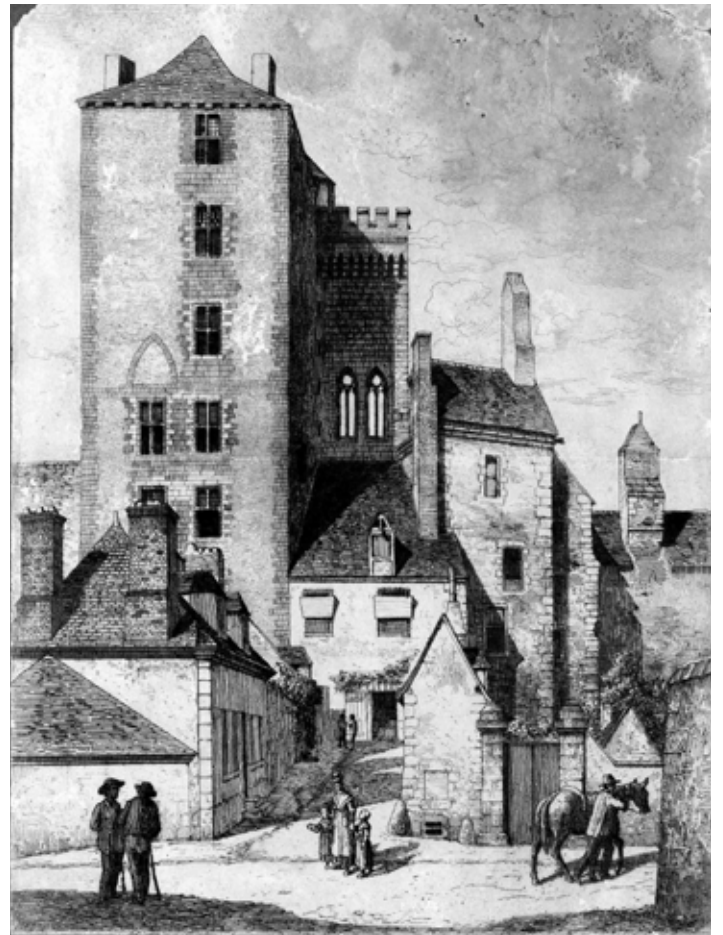
Château ducal des Bourbons, vue de la façade ouest du donjon surnommé la «Mal-Coiffée» Eau-forte sur papier de Hollande (1864-1866), Armand Queyroy
